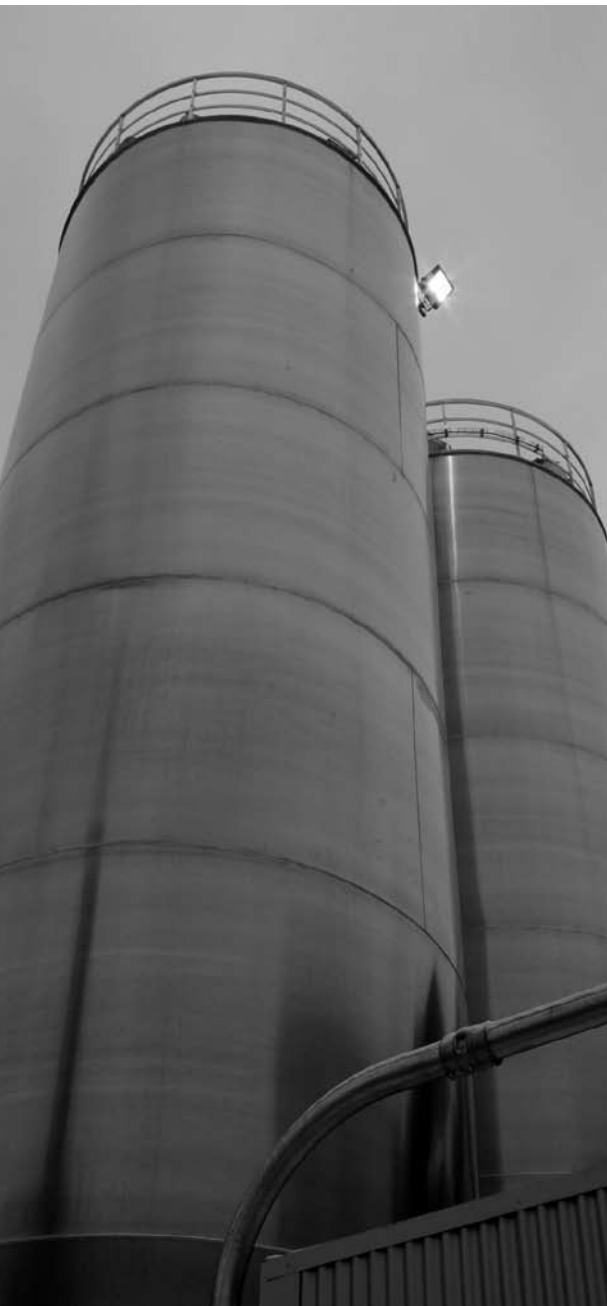
Deux silos de 200 m 3 pour stocker les pellets
