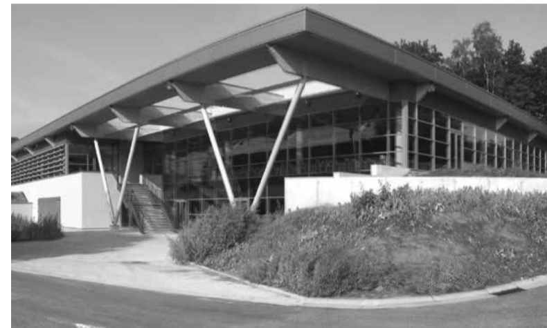
Le nouveau restaurant du Sart-Tilman construit dans l'esprit du "durable"
